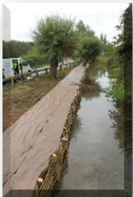
Renforcement des berges Calaisis
