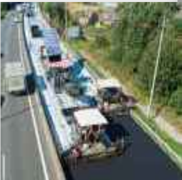
Requalification de la RD 301 section Hersin-Coupigny/Barlin
