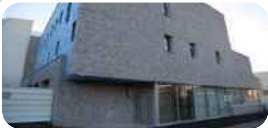
Reconstruction du Centre d'Incendie et de Secours
