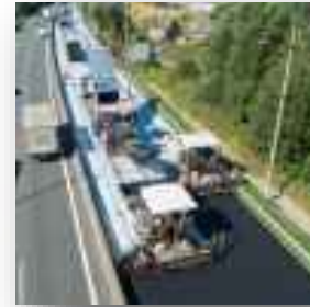
Septembre - Renouvellement de la couche de roulement RD 301 - Barlin Montant des travaux départementaux : 700 000 €
