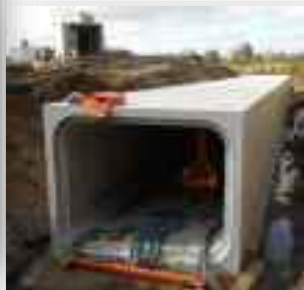
Réfection de l'ouvrage d'art de Mazinghem RD 186
