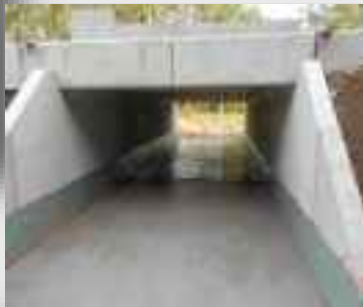
Requalification du passage piétons sous RD 945
