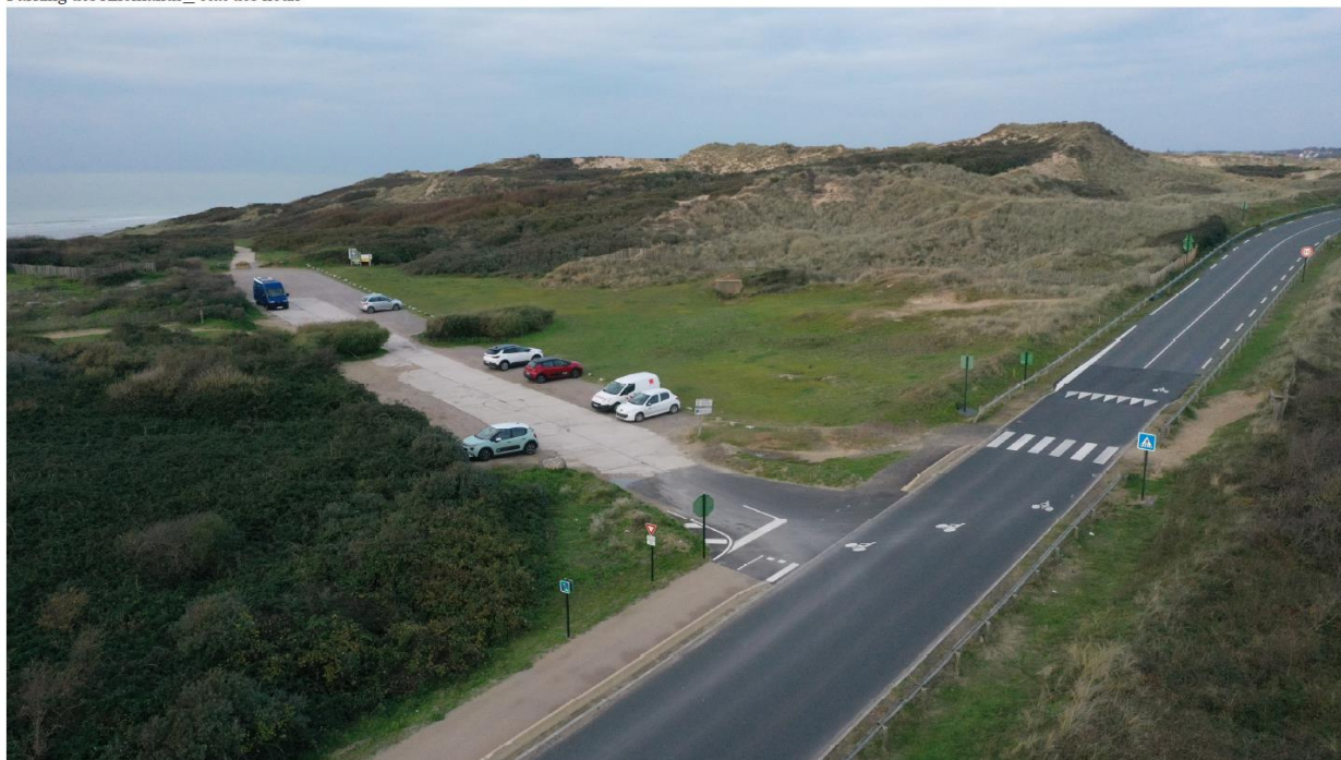
Parking des Allemands_ état des lieux
